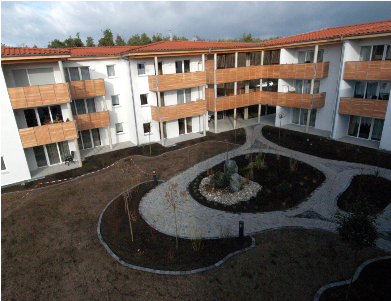
Blick in den Innenbereich der von der Bauen für Griesheim AG neu gebauten seniorengerechten Wohnungen in der Eichendorffstraße.
